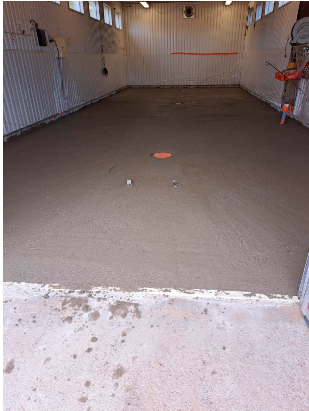
Kalimen nylkyhallin uuden lattian tekoa
